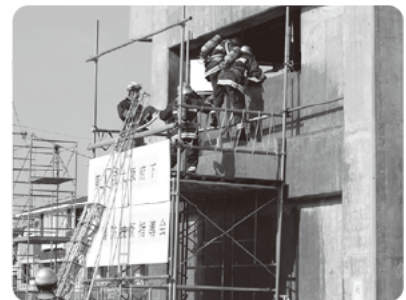
火元の部屋に進入して消火活動
