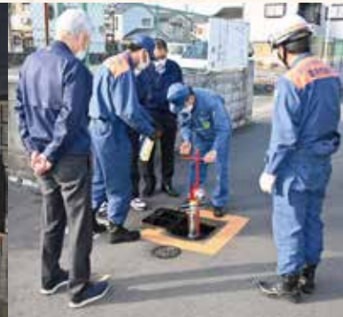
消火栓開栓資機材の取扱い
